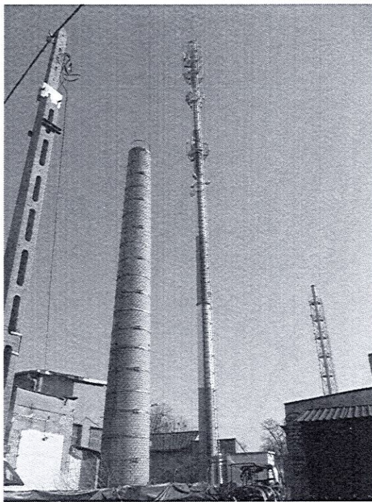
Zał. nr 1: Widok ogólny instalacji radiokomunikacyjnej.
