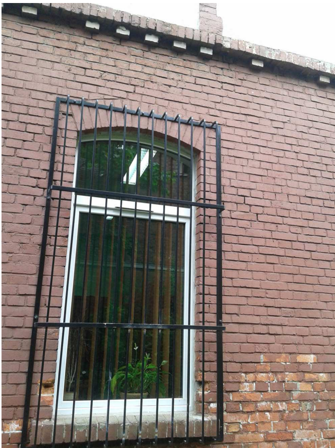
Kraty w oknach do demontażu,
