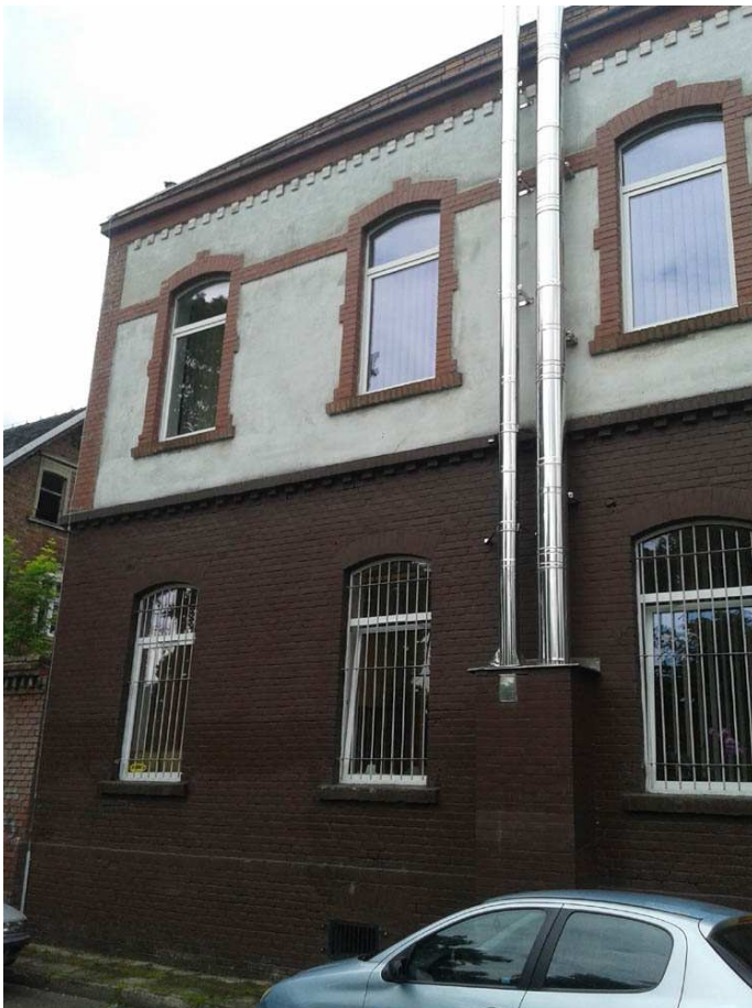
Przewody spalinowe – do demontażu.
