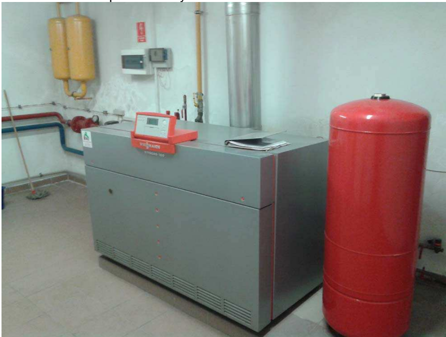
Kocioł gazowy i armatura kotłowni do demontażu.
