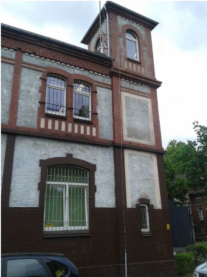
Elewacja północna – ściany wieżyczek do renowacji.
