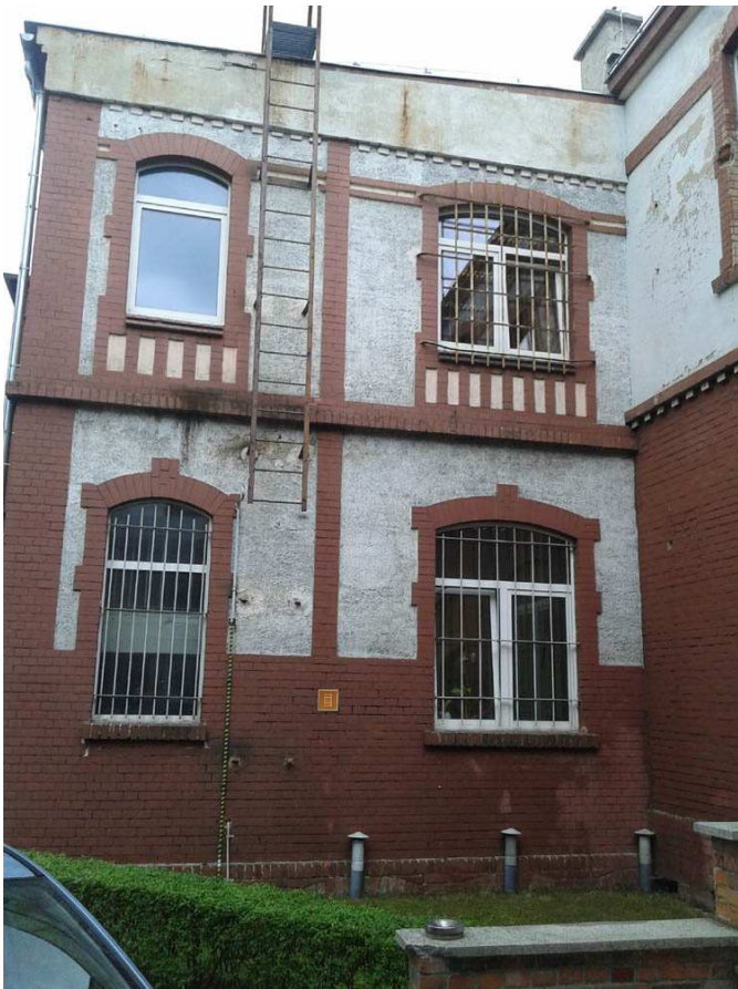
Kraty w oknach i drabina wejściowa na dach do demontażu,
