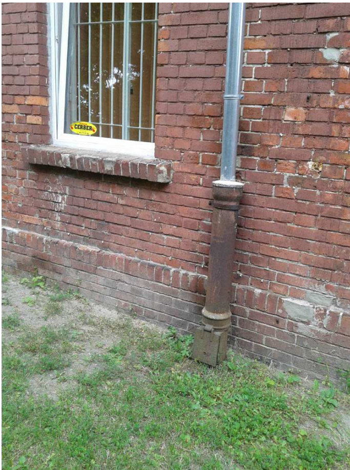
Przyziemie rur spustowych z rewizją.
