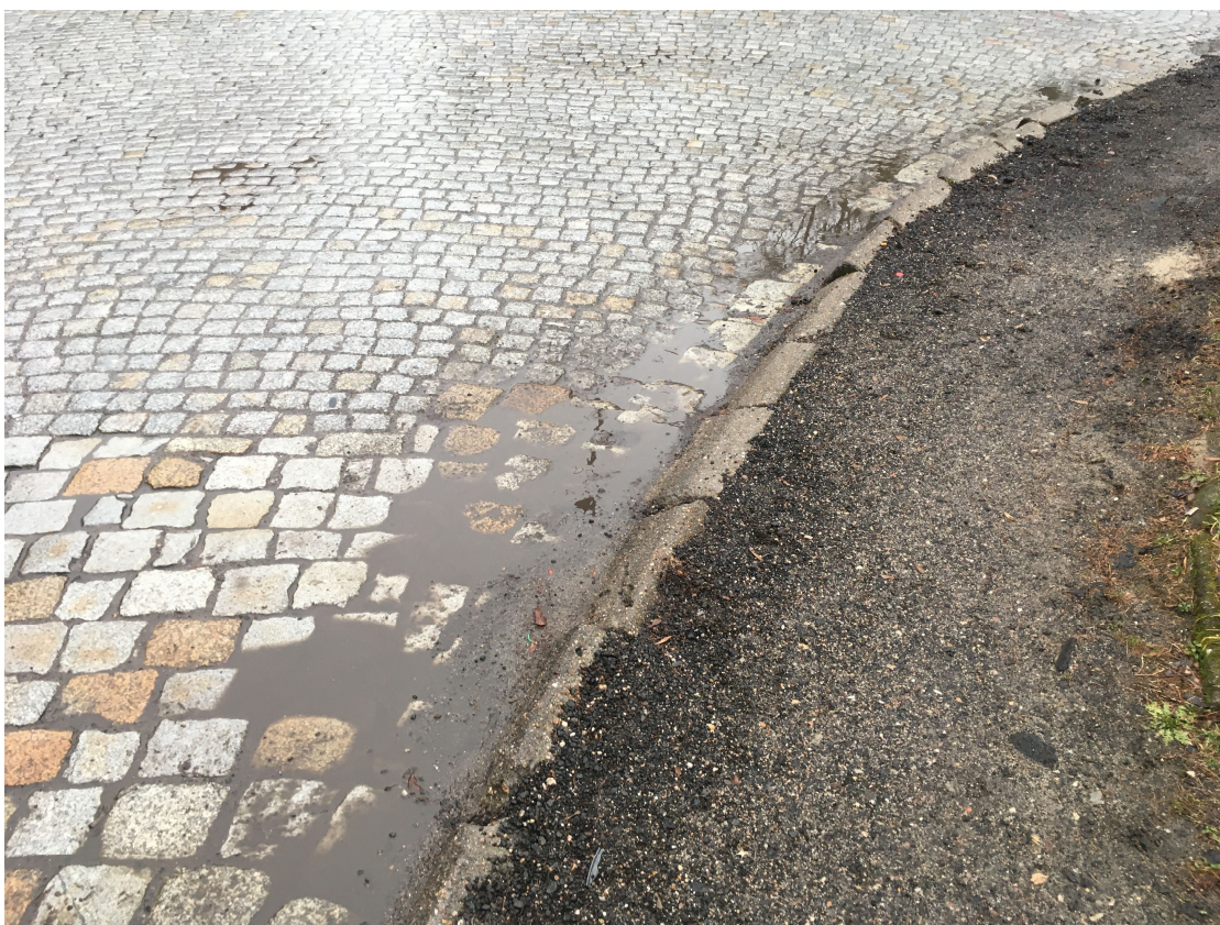
Zdjęcie nr 2. Istniejąca nawierzchnia w obrębie skrzyżowania.
