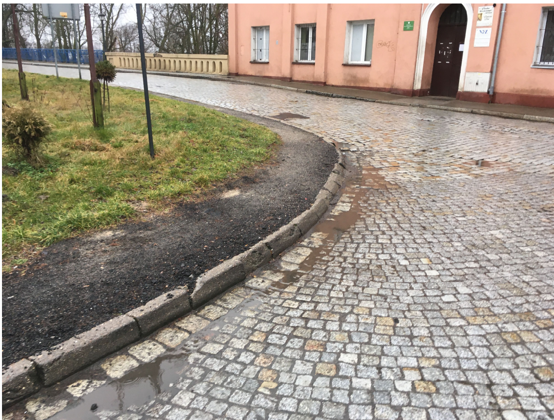
Zdjęcie nr 1. Istniejąca nawierzchnia skrzyżowania- zdjęcie od strony ul. Młynarskiej
