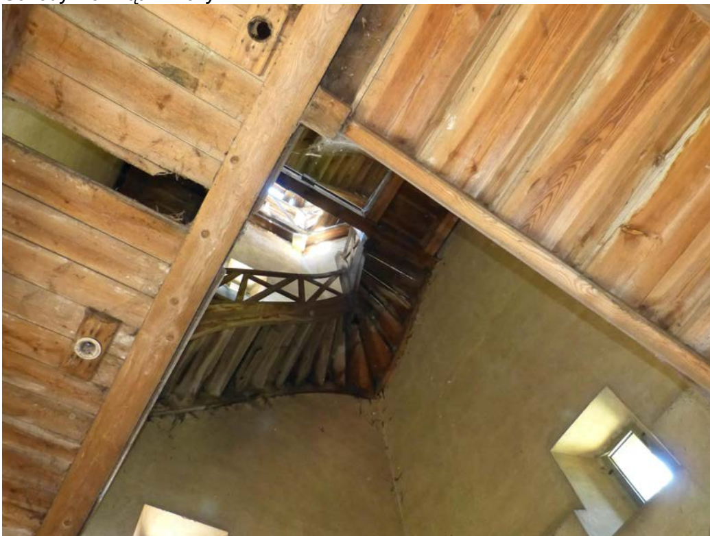
Schody wewnątrz wieży
