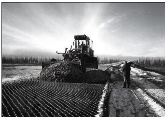
Rys. 9. Podbudowa nawierzchni drogowej wykonana przy użyciu geosiatki komórkowej
