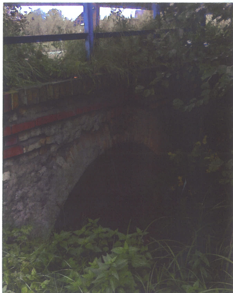
Fot.2. Prawy przyczółek, widać nadmurowany gzyms z cegły.
