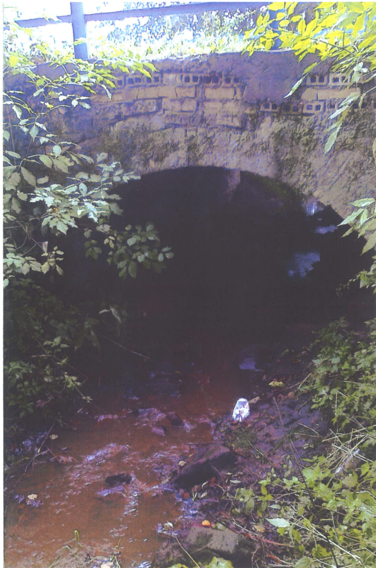
Fot.2. Prawy przyczółek, widać nadmurowany gzyms z cegły.
