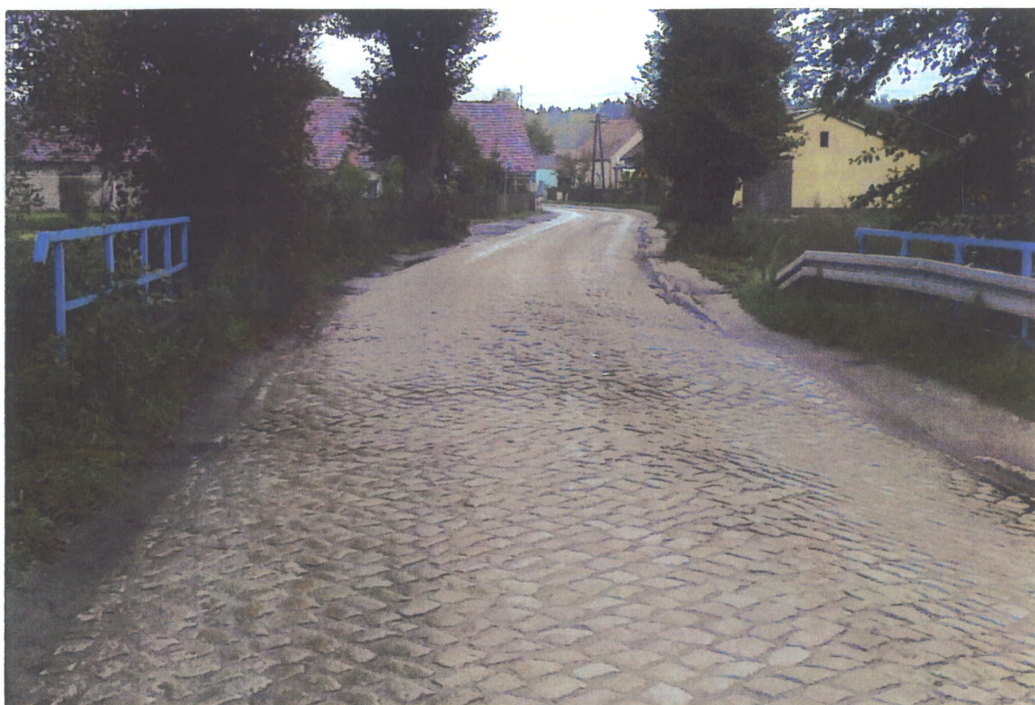
Fot.1. Widok istniejącej korony drogi. Widać miejsca zapadania się konstrukcji.
