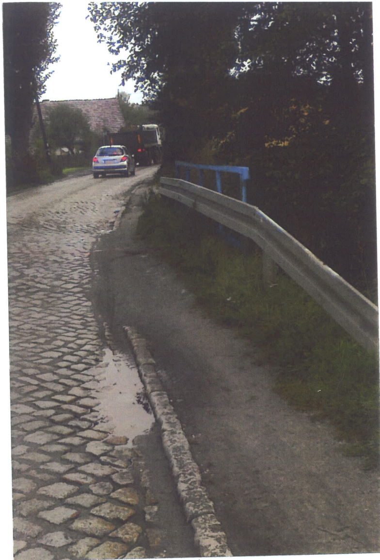
Fot.4. Strona lew – poręcz i bariera stalowa. Widać zapadliska w jezdni nad obiektem.
