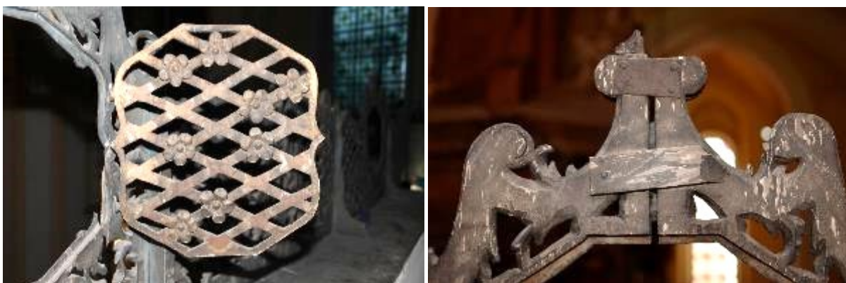
Ryc. 119. Detal. Po lewej: uchylne skrzydło kraty. Widoczne przetarcia warstwy pozłotniczej i ubytki detali dekoracyjnych. Po prawej: wtórne łączniki elementów snycerskich, ułamana fiala.
