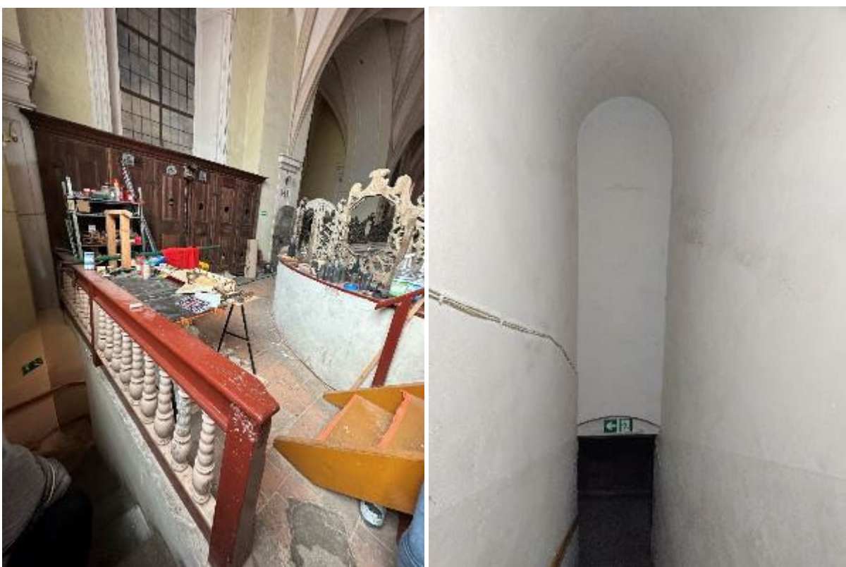
Ryc. 90. Górne wyjście z klatki schodowej (po lewej) i tylna ściana dolnego biegu.
