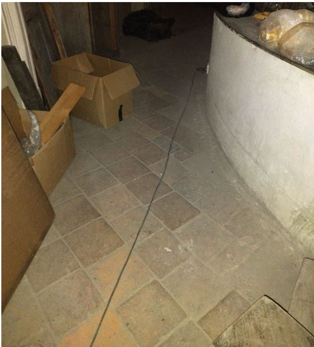
Ryc. 115. Fragment posadzki na emporze (138). Płytki ceramiczne na podsypce piaskowej o przybliżonych wymiarach 26 x 26-27 cm.
