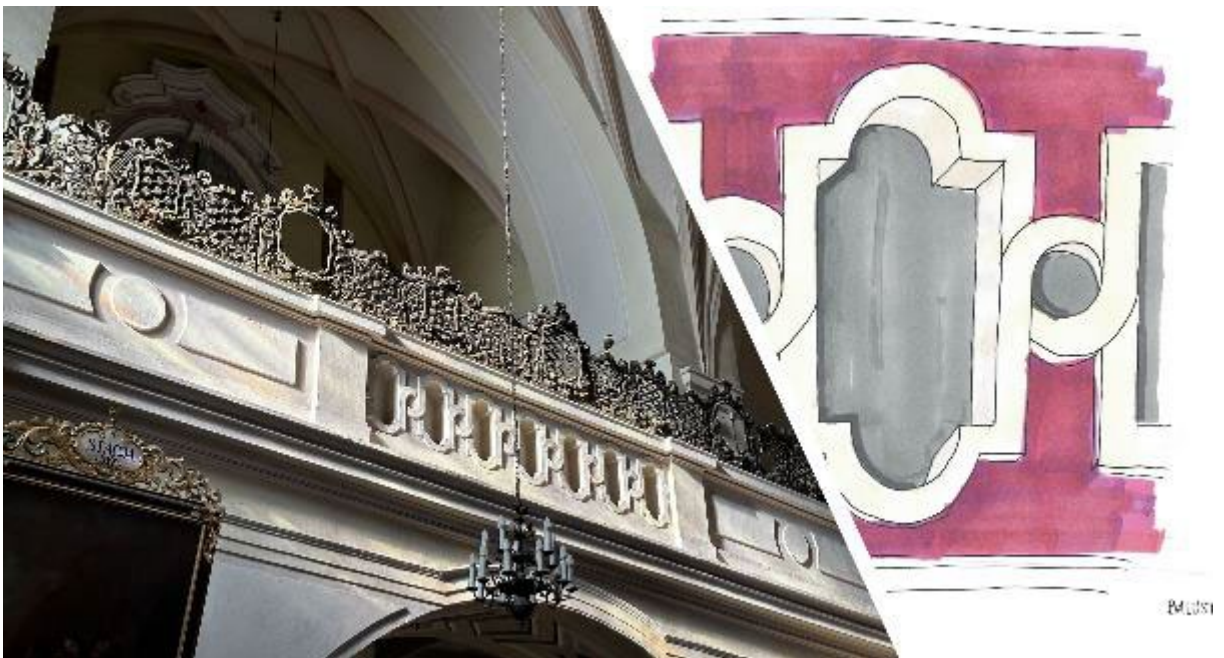
Ryc. 178. Schemat pierwotnej, XVIII-wiecznej kolorystyki detalu balustrady empory w nawie pñ. określony na podst. badań.
