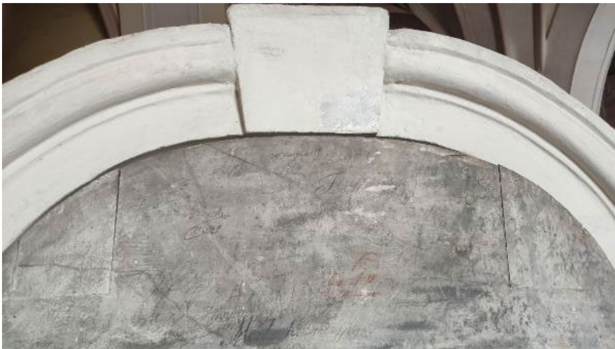
Ryc. 154. Kamienne odrzwia, obecnie pomalowane na biało. Skrzydło drzwiowe z oryginalną marmoryzacją oraz podpisami – zbliżenie na górną część. Widoczne inskrypcje m.in. daty 1819, 1832.
