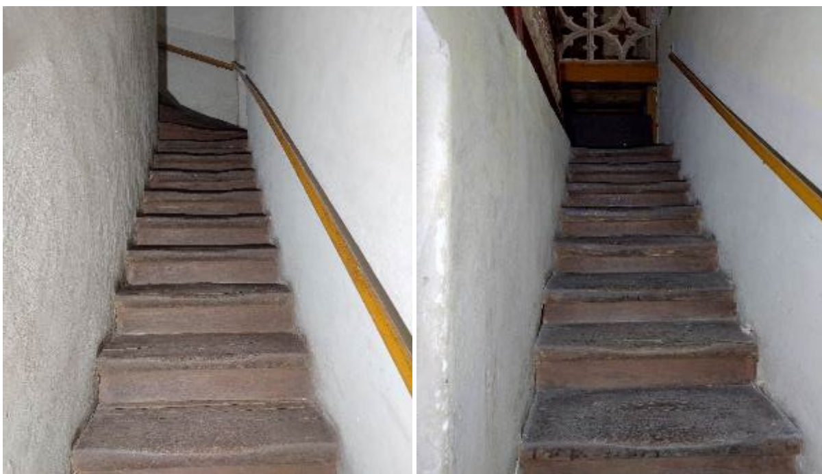
Ryc. 88. Widok dolnej (po lewej) i górnej części biegu schodowego.
