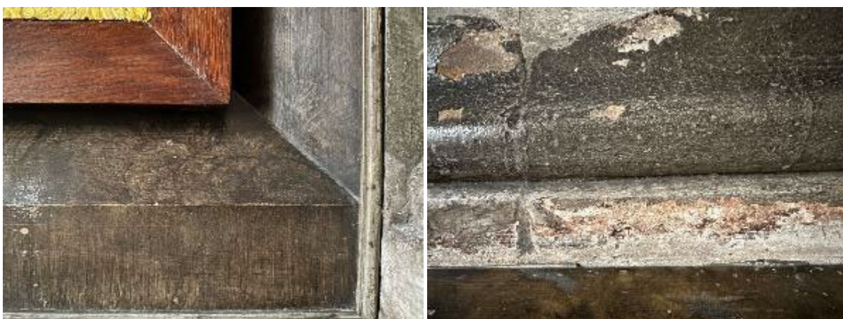
Ryc. 19. Mazerowana rama drewniana z końca XIX / początku XX w. (po lewej). Ryc. 20. Stan zachowania wtórnej, XIX/XX-wiecznej warstwy malarskiej na profilowaniu kamiennego epitafium (po prawej) – widoczne spękania i duże ubytki warstwy malarskiej.
