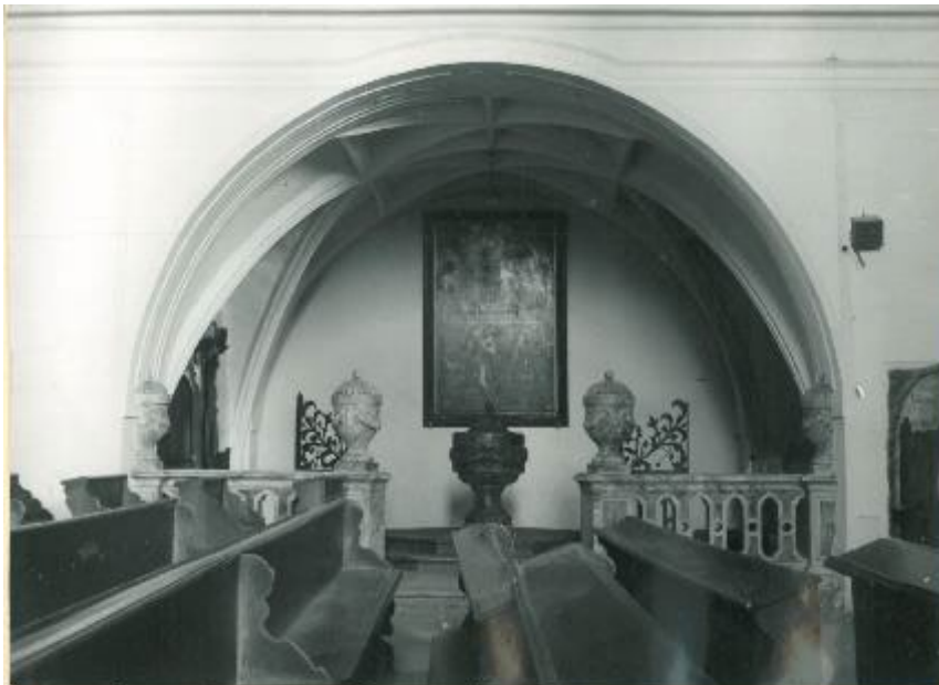
Ryc. 73. Kaplica Chrzcielna w 1959. Wnętrze pobielone. Źródło: Kutzner (PKZ. Wrocław).
