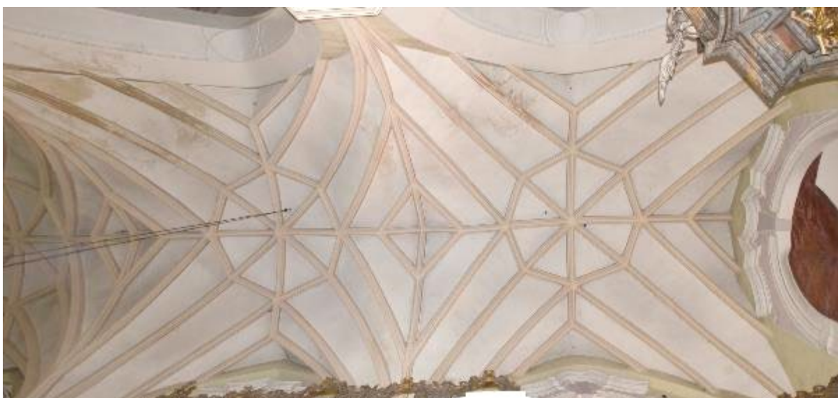
Ryc. 35. Nawa północna – przęsła sklepienia; od prawej: 028.1 i 028.2.
