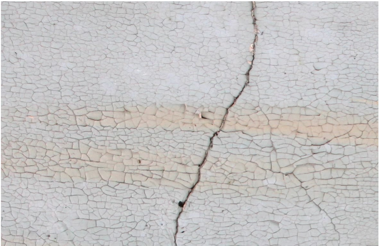
Ryc. 105. Polichromia na sklepieniu wnętrza 038 w przestrzeni ograniczonej konstrukcją loży opackiej – stan zachowania warstwy malarskiej tła.
