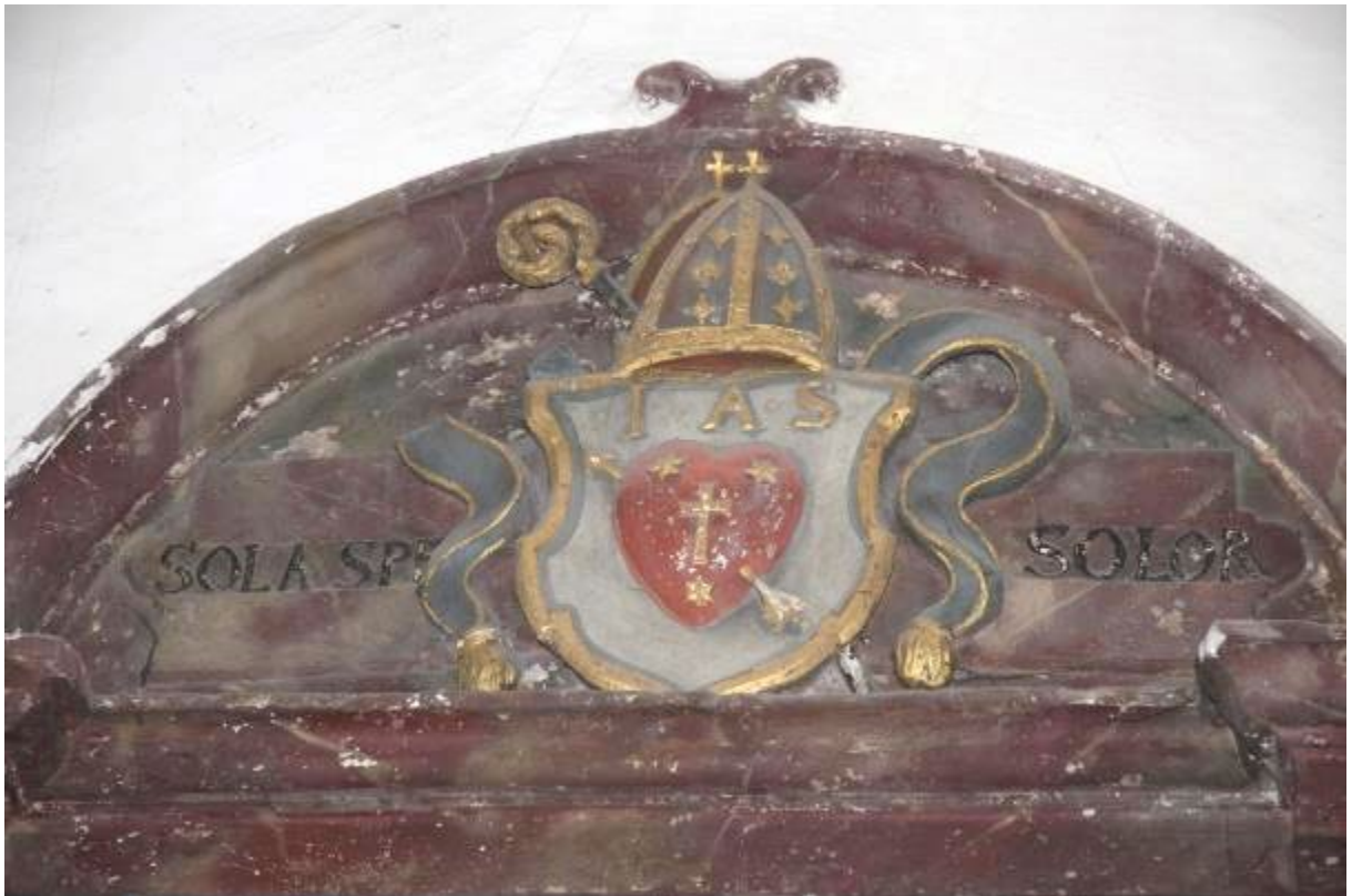
Ryc. 53. Zwieńczenie kompozycji rzeźbiarsko-architektonicznej obramienia. Widoczne nawarstwienia i miejscowe uszkodzenia.
