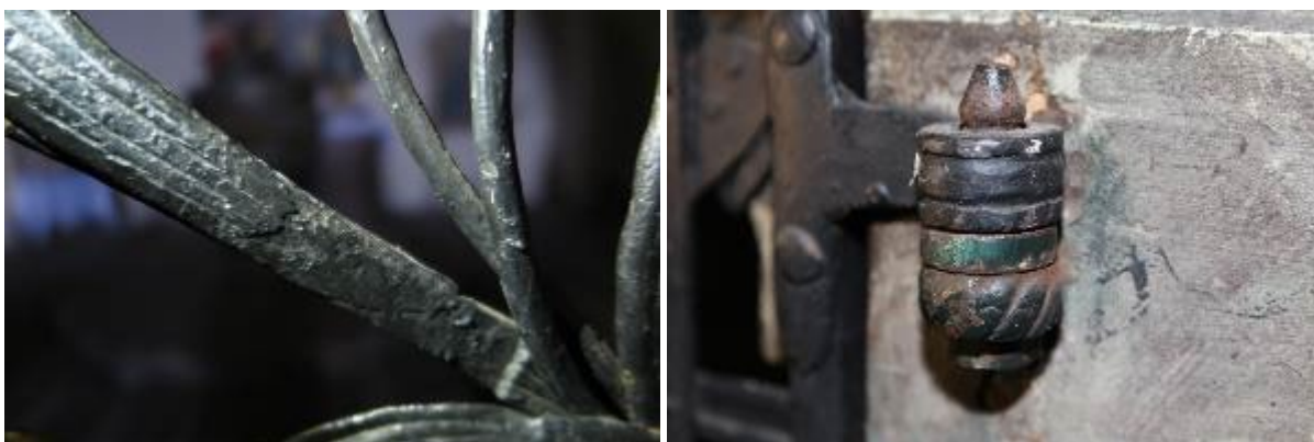
Ryc. 79. Detal. Po lewej: fragment metalowej kraty, którą zamknięta jest kamienna balustrada przed kaplicą. Widoczne nierówności powierzchni wskazują na obecność wcześniejszych warstw opracowania malarskiego lub pozłotniczego. Po prawej: zawias jednego ze skrzydeł furtki – czytelne relikty barwnego malowania metalu.
