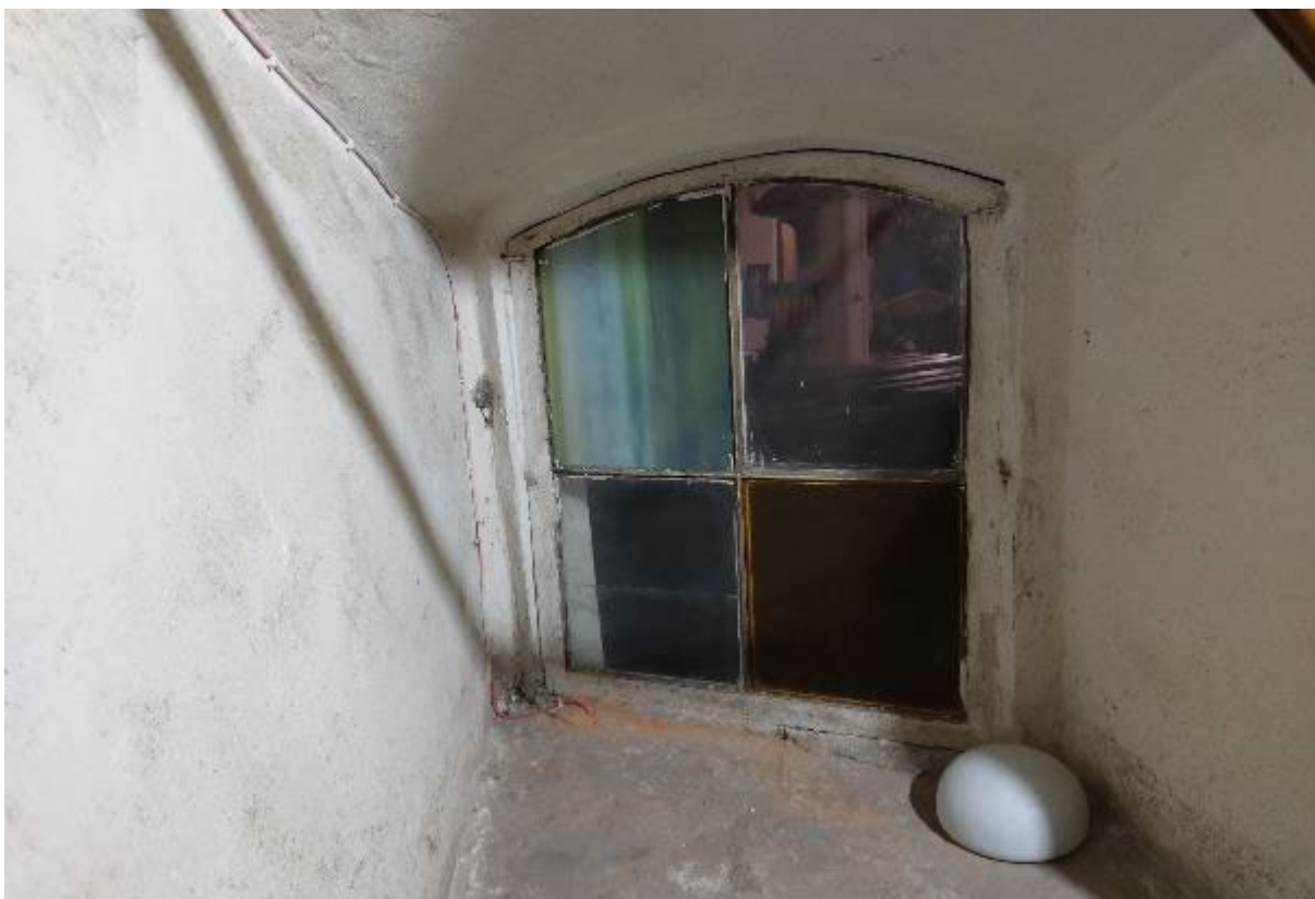
Ryc. 89. Wnęka okna do nawy północnej.
