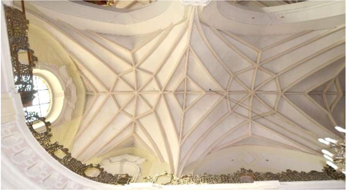
Ryc. 37. Nawa północna – przęśta sklepienia; od prawej: 028.4 i 028.5.
