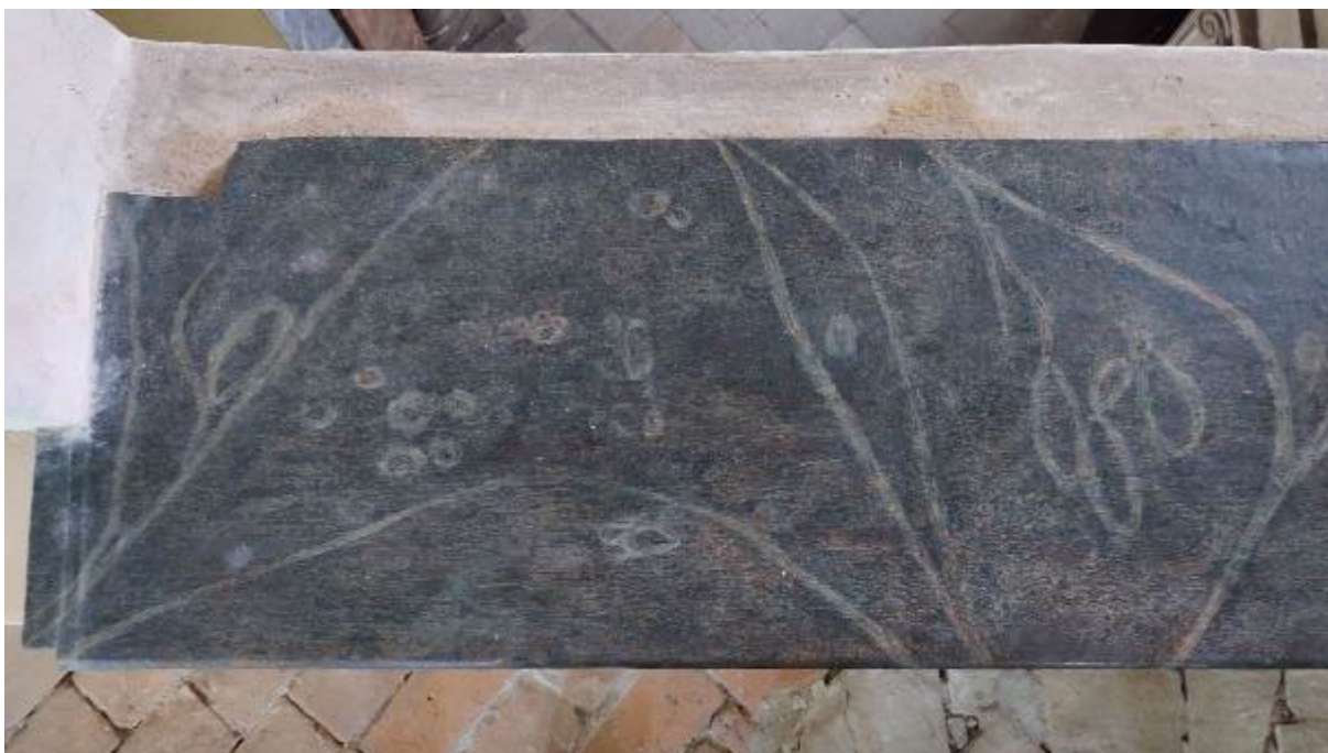
Ryc. 124. Fragment parapetu w oknie chóru zakonnego skierowanym ku nawie północnej – widoczna polichromia, analogiczne opracowanie jak poprzedniej fotografii (stan po ostatniej konserwacji w 2022). Ten sam sposób dekoracji malarskiej stwierdzono na całym ciągnącym się wzdłuż empyry parapecie pod kratą.
