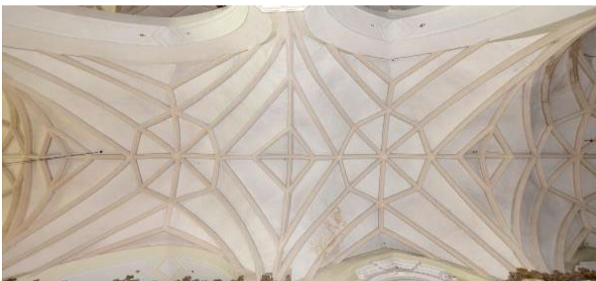
Ryc. 36. Nawa północna – przęsła sklepienia; od prawej: 028.3 i 028.4.
