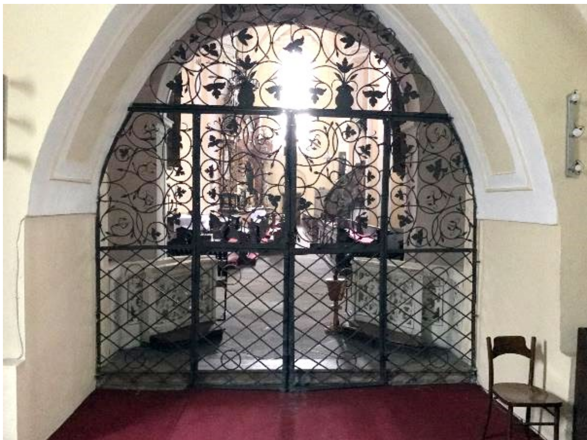
Ryc. 67. Arkada wejściowa od wnętrza kaplicy. Krata oraz barokowa balustrada poprzedzająca wejście do kaplicy.
