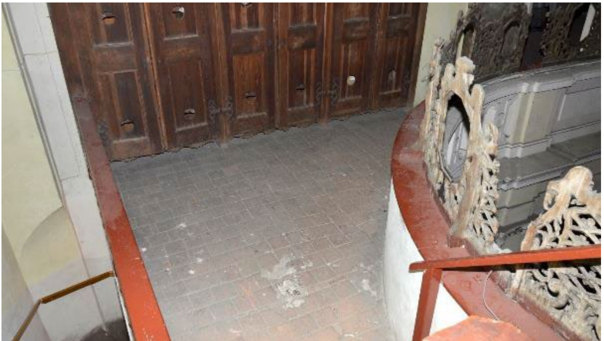
Ryc. 151. Widok na posadzkę chóru. Po lewej stronie widoczny bieg schodowy prowadzący w dół, ku nawie. W głębi widoczna zabudowana szafa na odzież i książki chórzystów. Parapet wzdłuż kraty regencyjnej pomalowany farbą olejną na brązowo.
