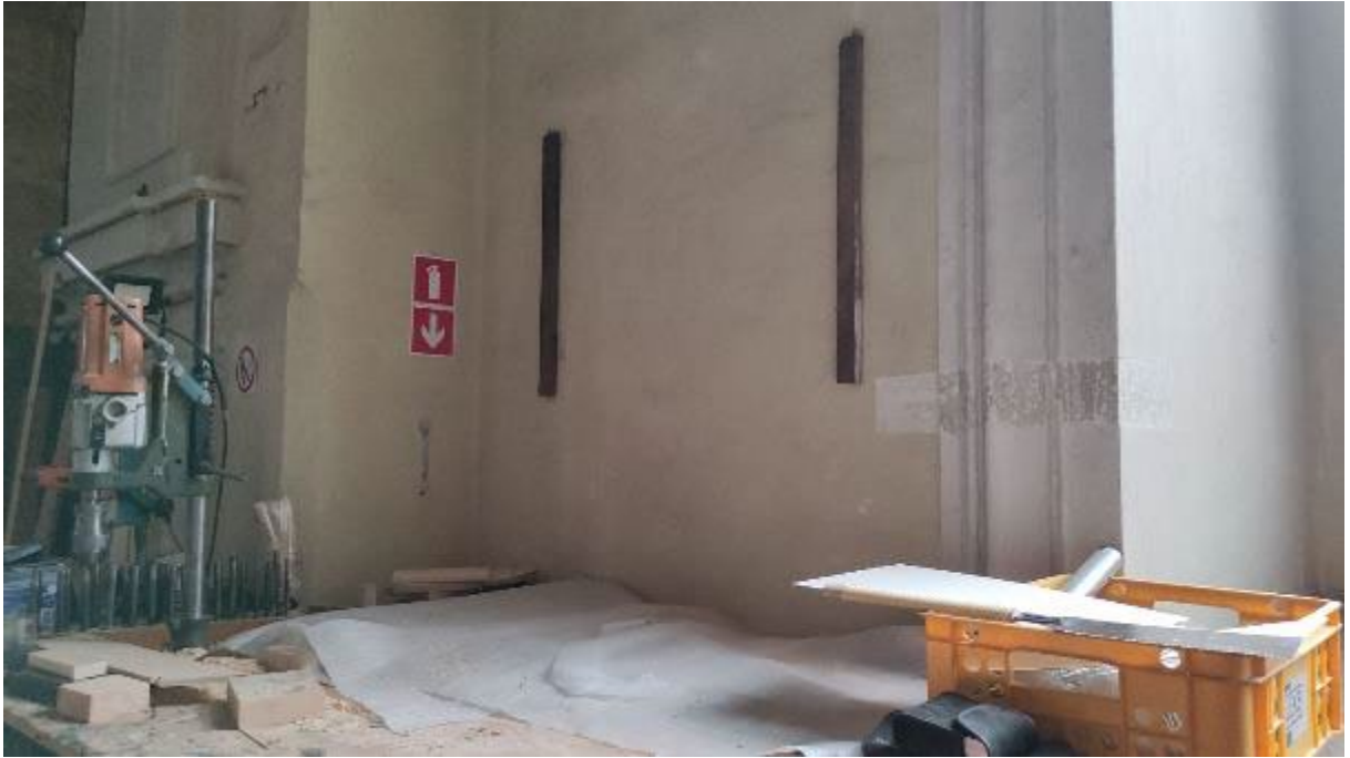
Ryc. 150. Ściana zachodnia. Widoczna odkrywka stratygraficzna nr 141.4 wykonana na obramieniu otworu okiennego.
