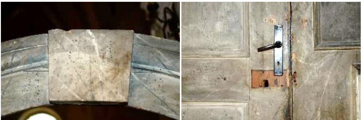
Ryc. 128. Zwornik w belce wieńczącej. Widoczne zachłapania farbą zostały być może intencjonalnie wykonane jako element swobodnie malowanej marmoryzacji. Po prawej: wtórnie wstawiony zamek i okucie.
