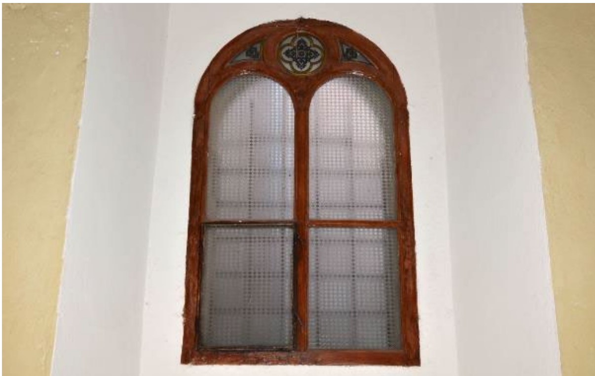
Ryc. 64. Stolarka okienna z XIX lub pocz. XX wieku z zachowanym w górnych partiach szkleniem o charakterze witrażowym. Cztery duże pola wypełnione wtórnie szkłem fakturowanym.
