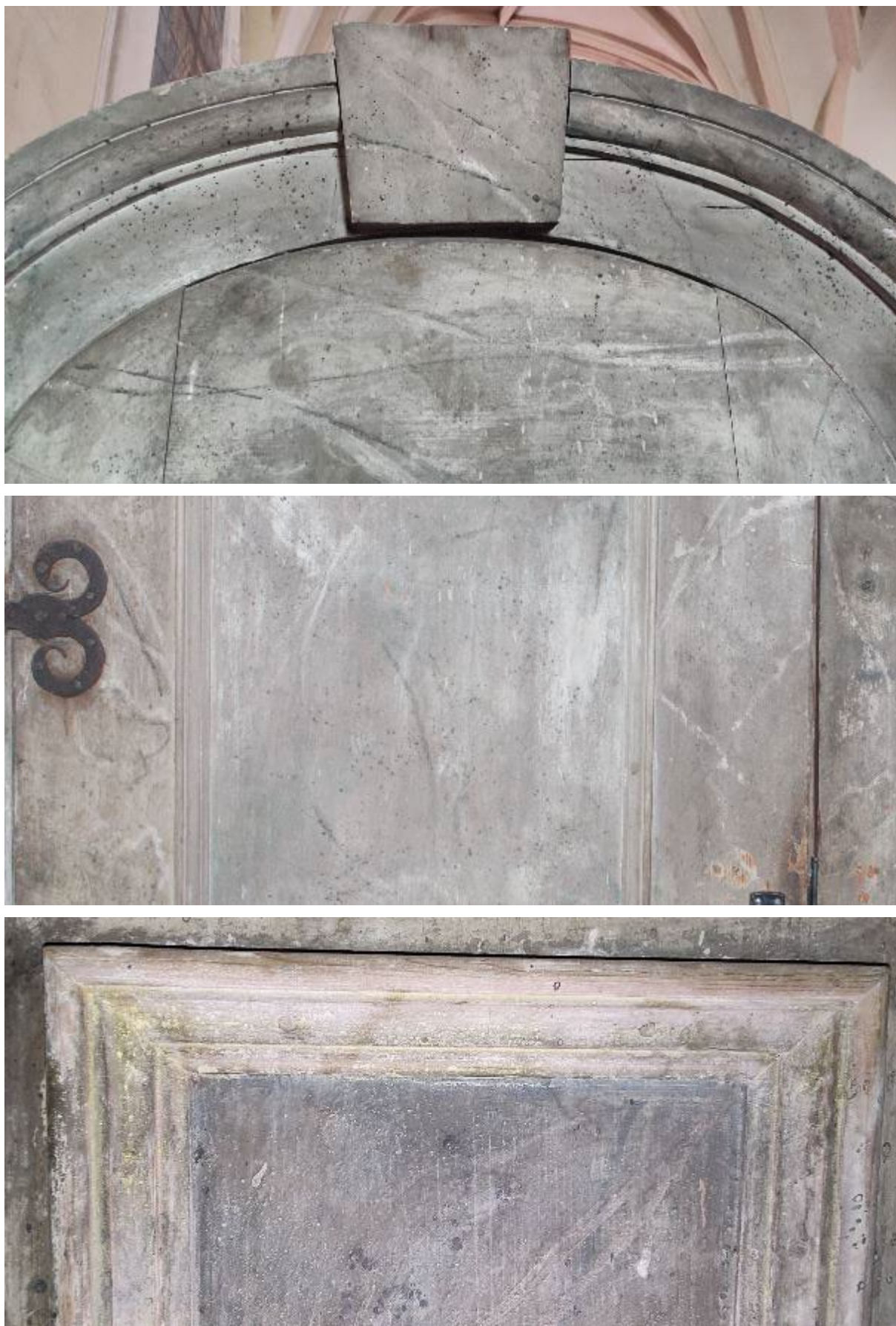
Ryc. 163. Barokowa marmoryzacja na elementach przegród empory stanowi punkt odniesienia dla sposobu opracowania malarskiego innych powierzchni. Zalecana konserwacja zachowawcza warstw malarskich.
