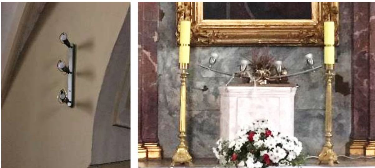
Ryc. 65. Oświetlenie kaplicy – stan obecny.
