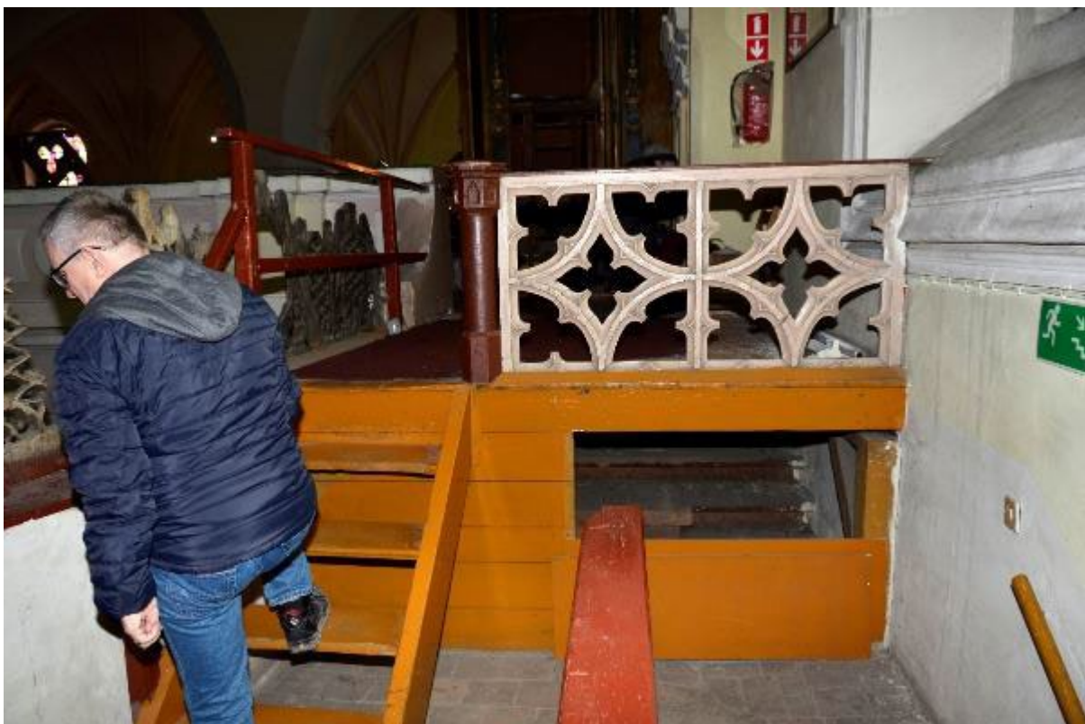
Ryc. 144. Widok z wnętrza 141 w kierunku południowym. Widoczny w głębi prospekt organowy, a po prawej fragment zachodniej ściany świątyni – intensywne nawarstwienia na glifie okna. Na pierwszym planie neogotycka balustrada ze słupkiem.
