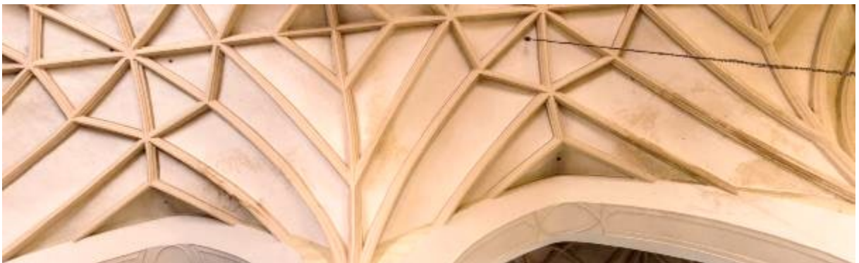
Ryc. 39. Przęśta 028.1 i 028.2 – stan zachowania sklepień w sąsiedztwie filarów międzynawowych – widoczne dalsze zniszczenia wypraw tynkarskich.
