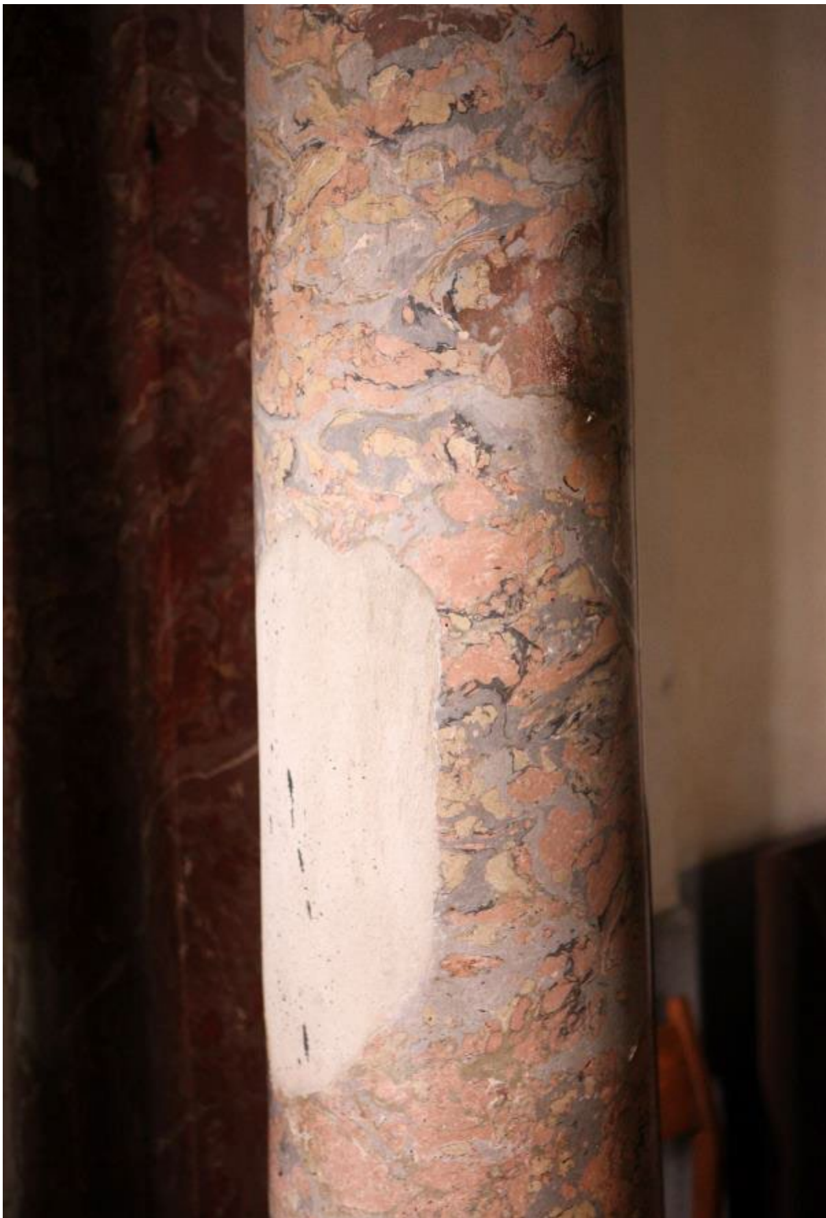
Ryc. 100. Łoża opacka, kolumna północna. Widoczne rozległe uzupełnienie ubytku wykonane przy użyciu zaprawy mineralnej bez scalenia kolorystycznego (kompozycyjnego).
