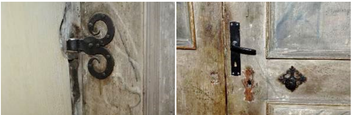
Ryc. 129. Detal. Po lewej: oryginalny, XVIII-wieczny zawias pasowy wraz z hakiem. Po prawej: współczesna klamka i relikw dawnego zamknięcia.
