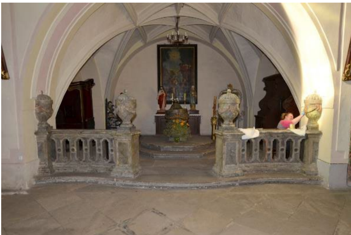
Ryc. 71. Balustrada wygradzająca przestrzeń Kaplicy Chrztelnej (otwarta furta).
