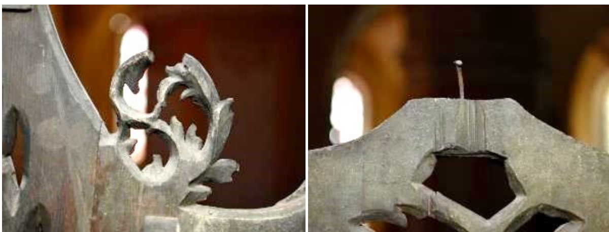
Ryc. 123. Detal. Po lewej: uszkodzony detal – liść akantu. Widoczna zachowana polichromia rewersu (charakterystyczne żyłkowanie malowanej marmoryzacji). Po prawej: brak sterczyny.
