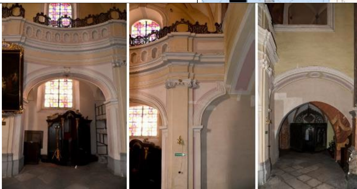
Ryc. 3. Północna ściana nawy bocznej północnej. Na pierwszym planie arkada oddzielająca część oznaczoną 028.1 od 0.28.a. Na fotografii obok wschodnia część arkady pod emporą z widocznymi odkrywkami stratygraficznymi w obrębie ślepej arkady, archiwolty, podniebienia łuku z kasetonem. Po lewej wschodnia ściana nawy północnej z widocznymi odkrywkami stratygraficznymi. W głębi pomieszczenie 026.
