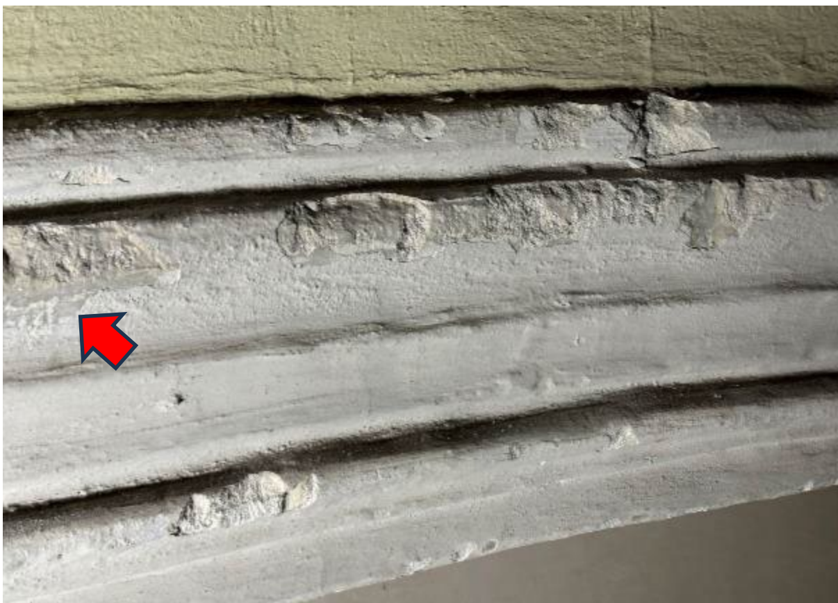
Ryc. 5. W ubytkach wierzchnich warstw (przemalowań) widoczne szare opracowanie malarskie profilu sztukatorskiego arkady.
