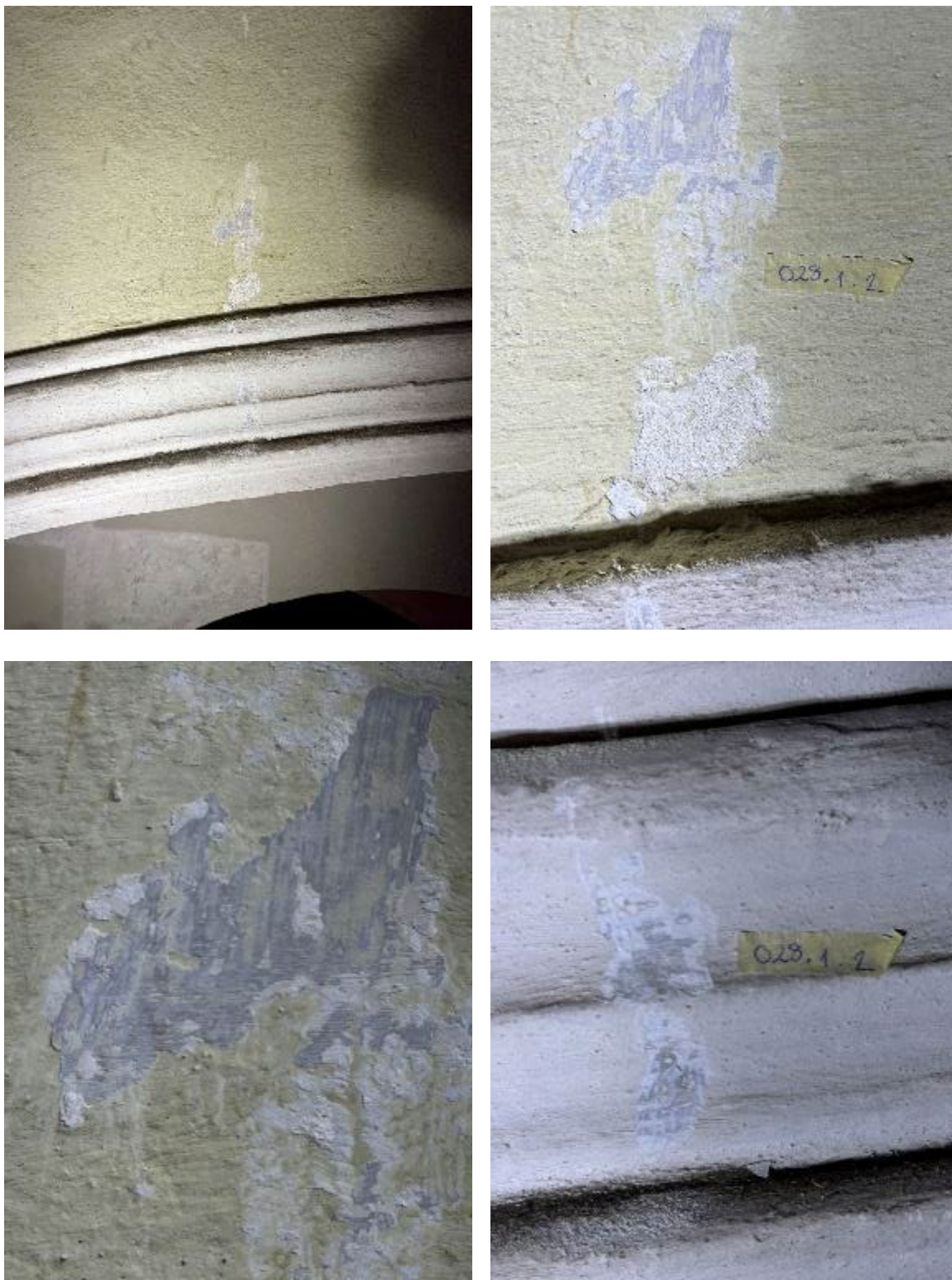
Ryc. 6. W odkrywkach, pod przemalowaniami, widoczna częściowo zachowana, szara, gładko opracowana powierzchnia tynku i profili sztukatorskich.
